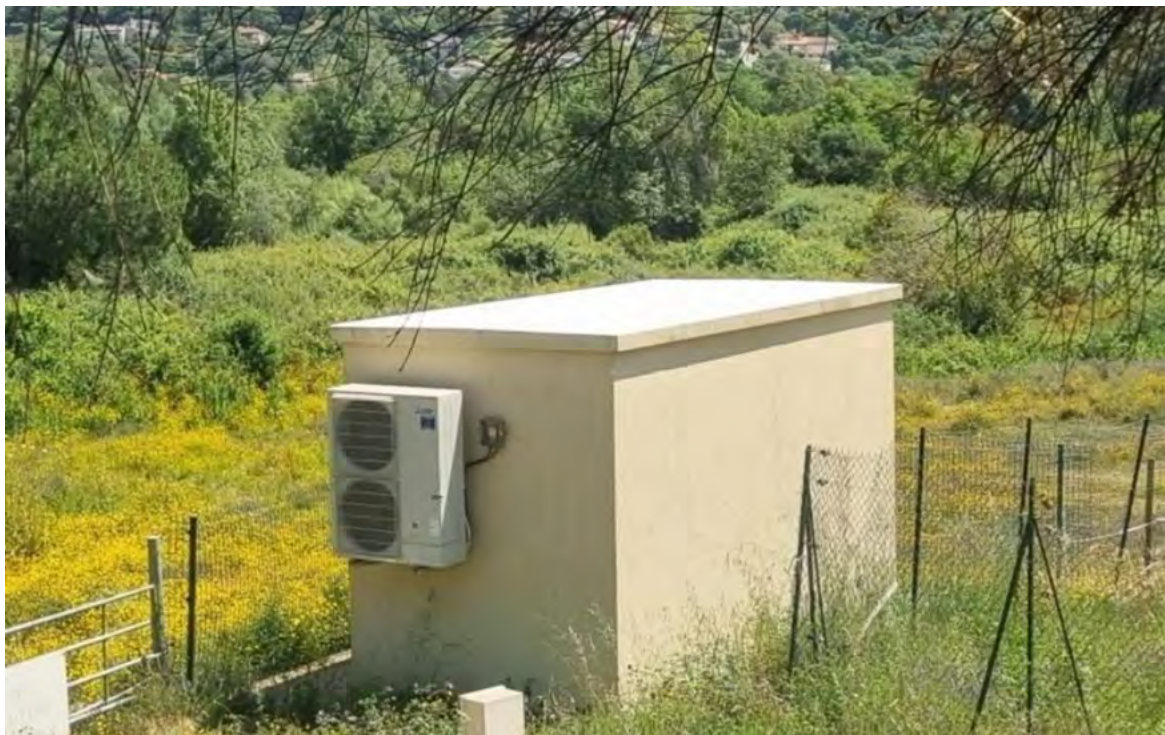
Photo du premier NRO test peint en Corse en mai 2025.
